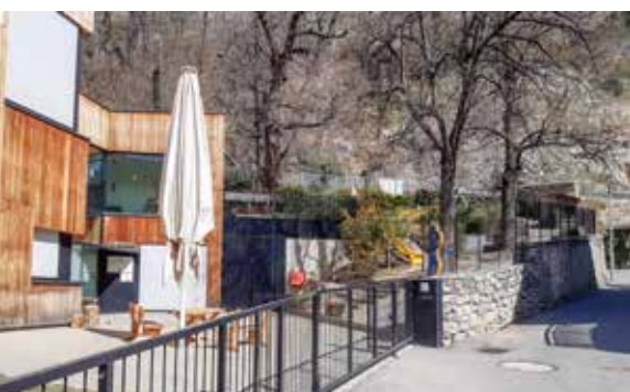
Die Umzäunung am Kindergarten Schlanders wird verbessert
