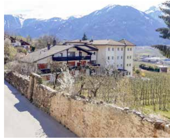
Die Rückseite des Sporthotels Vetzan vom Friedhof aus gesehen. Vorne die Mauer, die nun abgetragen wird, damit auch ein Gehweg errichtet werden kann.
